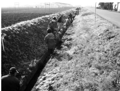
地域共同による水路の土砂上げ
