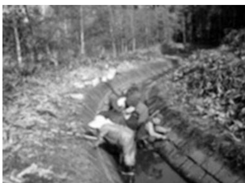
地域共同による水路の目地補修
