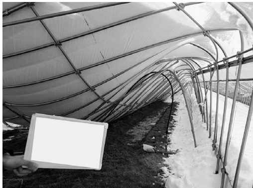
大雪により圧壊したビニールハウス (H29. 12. 12)
