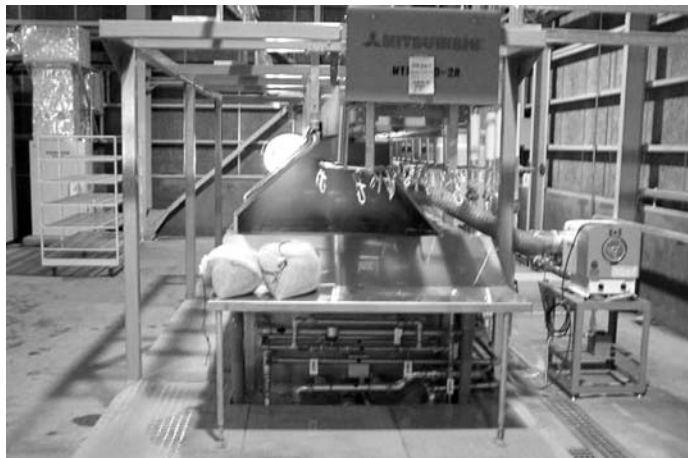
試験運用中の種粒温水消毒施設（一部）
