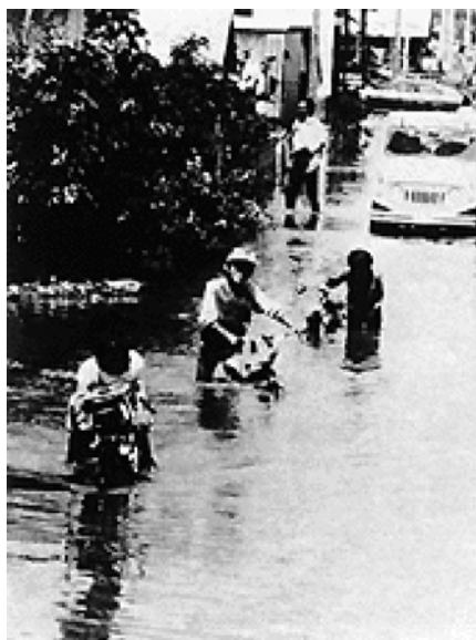
昭和50年8月22日～24日 帯広川の溢水氾濫により湖と化した住宅街（帯広市西13条南2丁目付近）
