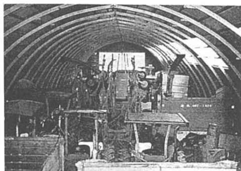
農機具格納庫の内部
