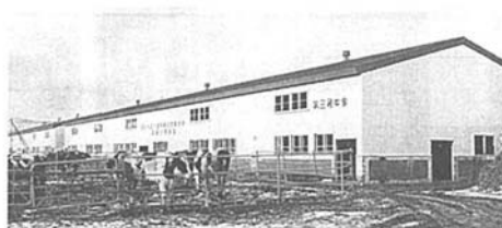
第2次農業構造改善事業による育成施設
