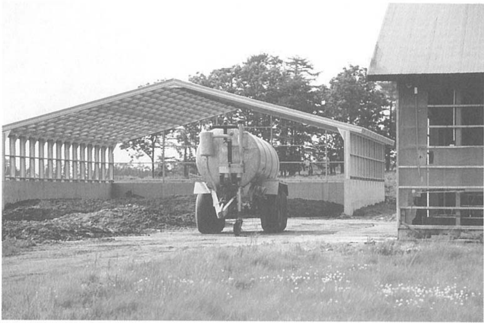
▲堆肥盤とスラリータンク
