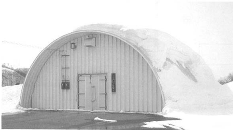
図3 1989年に愛別町に建設されたアイスシェルター (貯氷量 160t、ジャガイモ貯蔵量 100t、床面積 253 m 2 )
