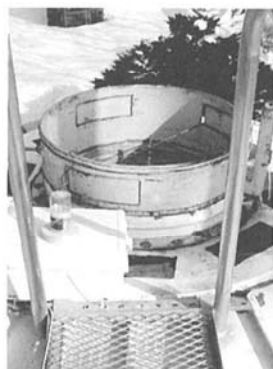
アイスシェルター上部の排気孔（冬期の製氷時期に排気孔として使われ、その後は密閉される）
