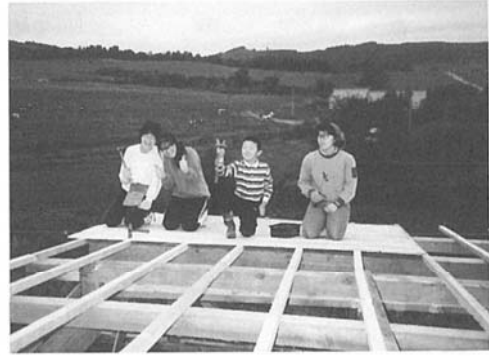
実習生たちと牛舎増築（屋根板張り）
