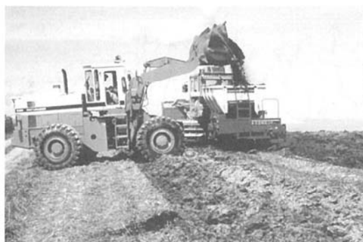
有材心破の施工状況
