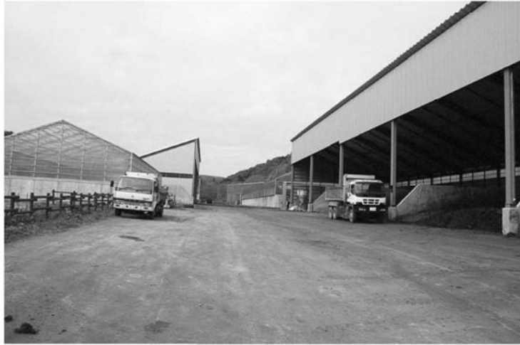
堆肥センター
