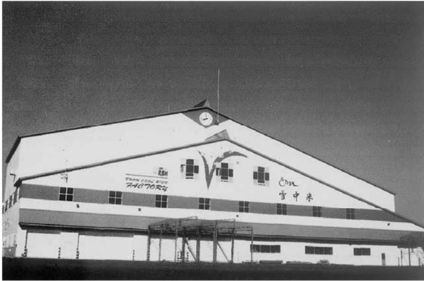
沼田町の米穀低温貯留乾燥調整施設（雪中米施設）
