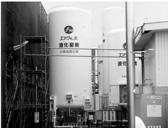
写真4 液体窒素のタンク
