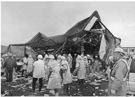
飛ばされたトンネル工事関係の事務所
