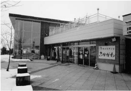
道の駅「ライスランド ふかがわ」の全貌
