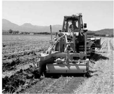
カッティングソイラ工法施工の様子
