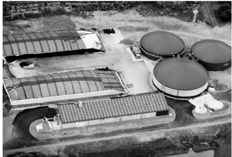
グロスパールドルフ村のバイオマス発電施設 右から時計回りに発酵槽、発電装置、デントコーンのトレンチ・サイロ
