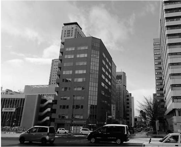
新事務所ビル(中央) ～札幌駅北口方向を臨む～
