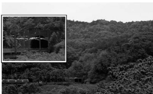
青函トンネル出入口
