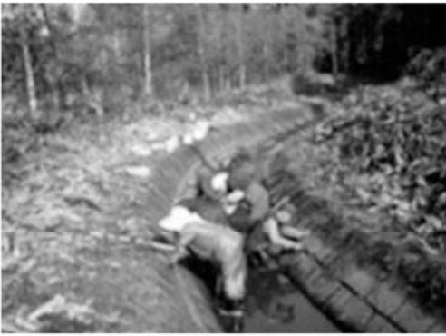
地域共同による水路の目地補修
