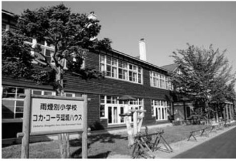
雨煙別小学校 コカ・コーラ環境ハウス
