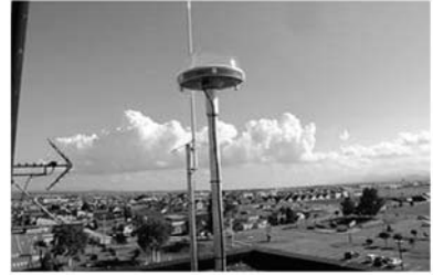
役場屋上アンテナ
