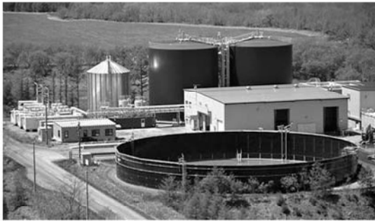
バイオガスプラント
