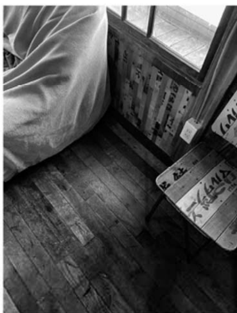
窓の下に壁に木箱が！途中で待ったをかけたので、ここだけ貼られています。
