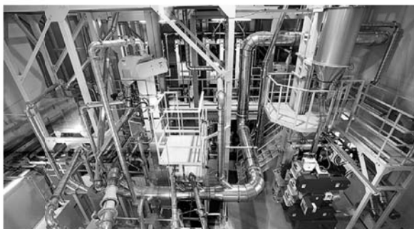
▲精米室（精米施設）
