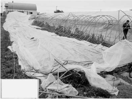
台風21号により倒壊したビニールハウス (H30. 9. 5)
